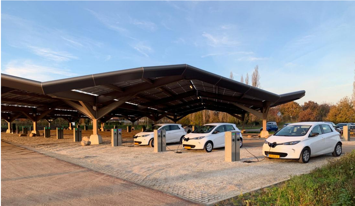
Figuur 26 Het bi-directionele laadplein met overkapping met zonnepanelen bij het hoofdkantoor van de Triodos Bank.
